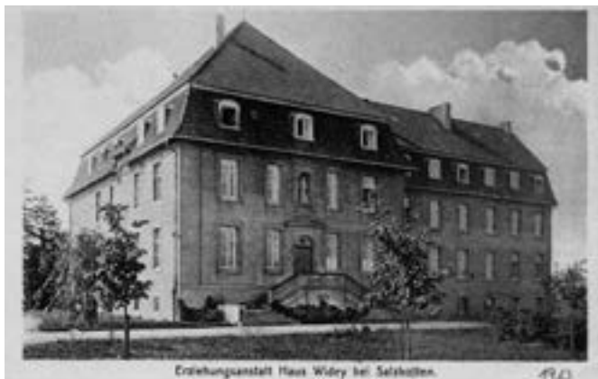
Erziehungsanstalt Haus Widey bei Salzkotten.
