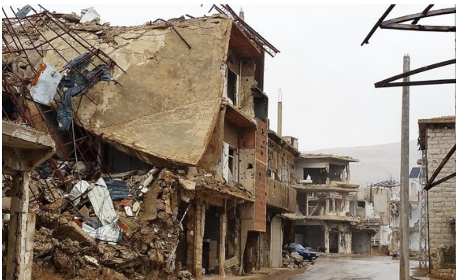
In Teilen von Aleppo sind die Zerstörungen durch den seit sieben Jahren andauernden Krieg unübersehbar. Foto: Christian Hope Centre
